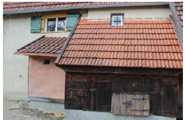
Die Schweine im Stall beim Haus Aichelau futterten die Abfälle
