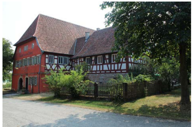
Der Gasthof zum Ochsen wurde nach einem Brand wieder aufgebaut.
